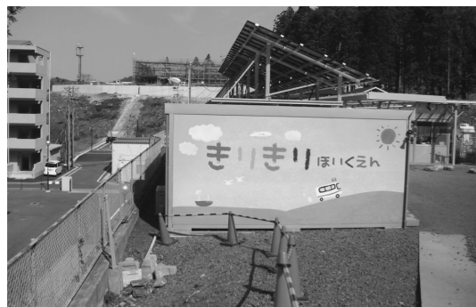
▲きりぎり保育園の仮園舎の後方に新園舎建築中
